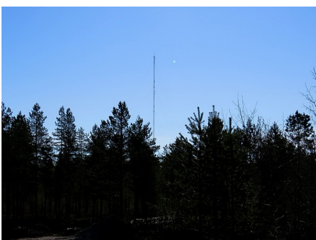
Kuva 12. Tuulimittaustorni voimalapaikkojen T06 ja T11 välissä.
