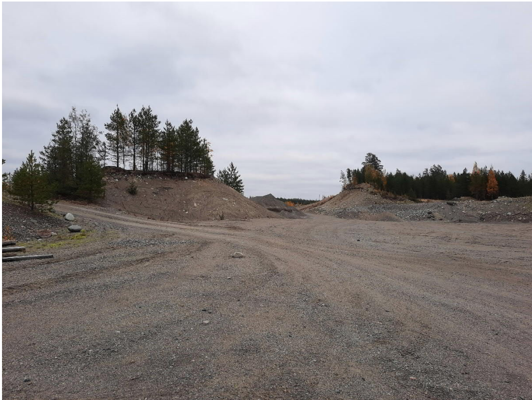
Kuva 16 Yleiskuva maa-ainesten ottoalueelta, jonka toiminta on loppunut.
