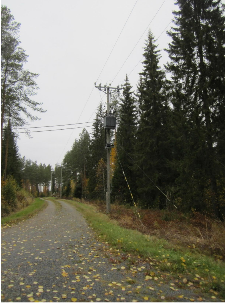
Kuva 17 Pylväsmuuntamo Lohijoen vedenottamon lähellä.
