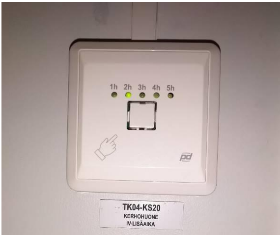
Kuva 63. Kerhotilassa on lisäaikapainike ilmanvaihdon tehostukselle
