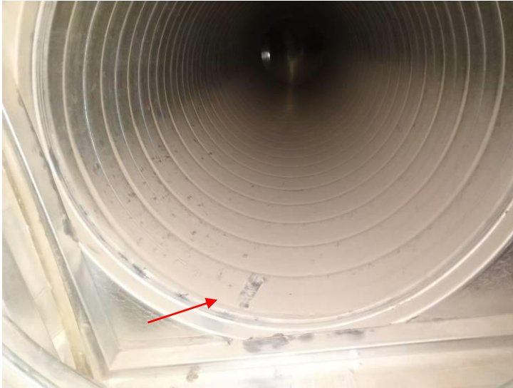
Kuva 17. Poistoilmarunkokanavassa havaittavissa pölyä pyyhkäisymenetelmää käyttäen.
