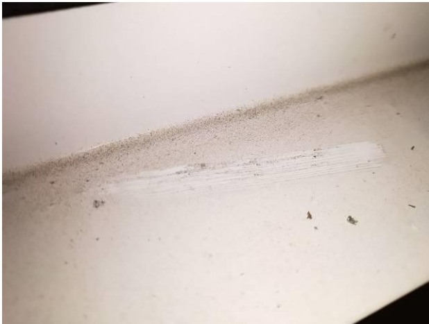
Kuva 79. Tulopäätelaitteissa havaittavissa likaantumista
