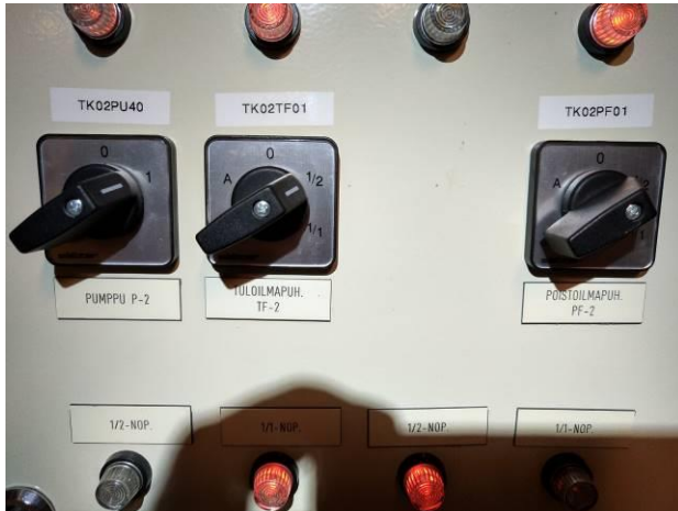
Kuva 25. TK02 on toteutettu 2-nopeus tekniikalla
