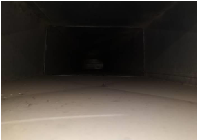
Kuva 55. Poistoilmarunkokanava oli päässyt selkeästi likaantumaan.
