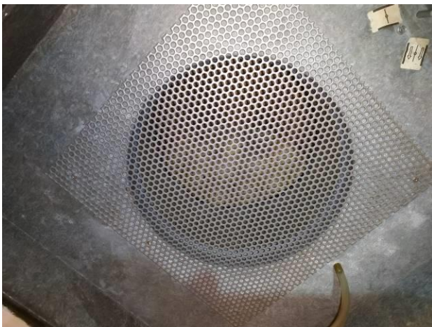
Kuva 81. Keittiön toimiston tulopäätelaitteessa hankala rakenne puhdistusta ajatellen
