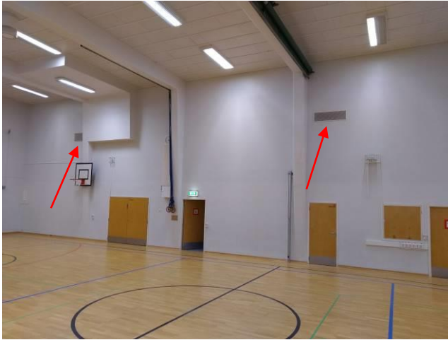
Kuva 47. Liikuntasalin poistoilmasäleiköt
