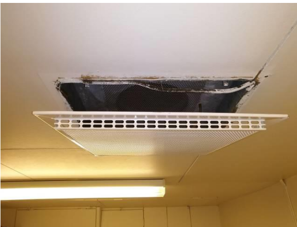
Kuva 78. Toimiston tulopäätte heikossa kunnossa tiivistyksien osalta
