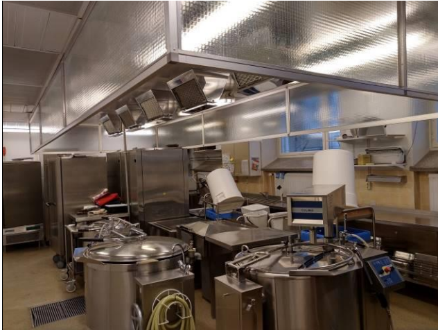
Kuva 72. Keittiön rasvahuuva
