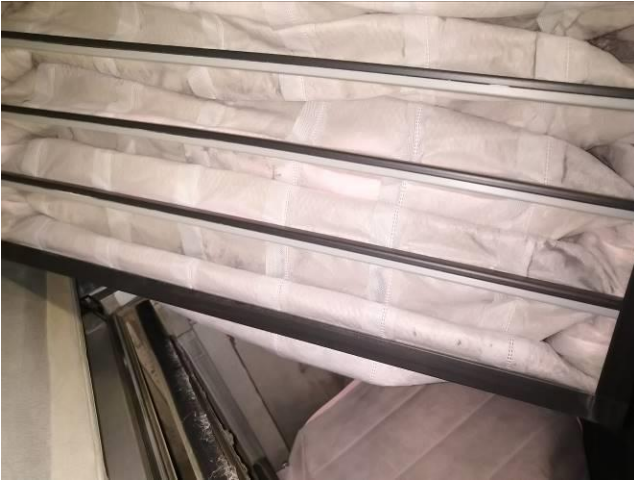
Kuva 53. Tuloilmasuodatin oli tarkasteluhetkellä kohtalaisen puhdas
