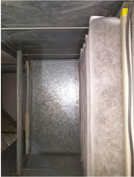
Kuva 82. Paikoillaan olleessa G3/G4 poistosuodattimessa erittäin lyhyet pussit
