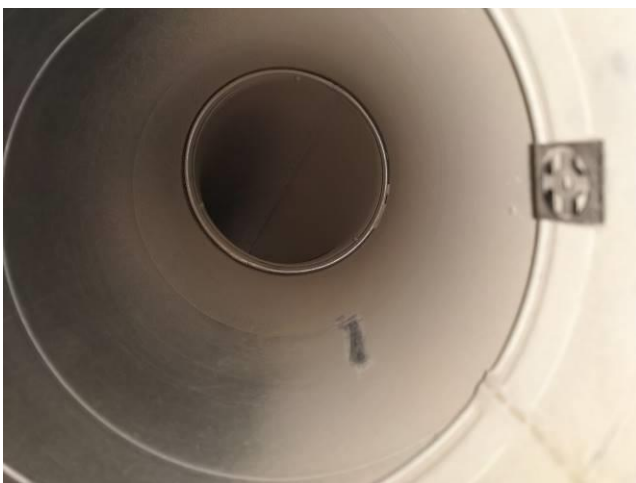
Kuva 66. Poistoilmakanavistossa pölykertymää
