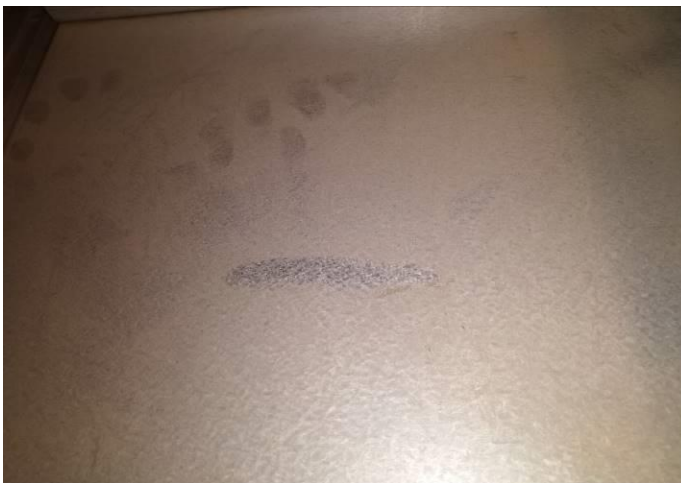
Kuva 56. Poiston puhallinkammiossa likaantumista havaittavissa.
