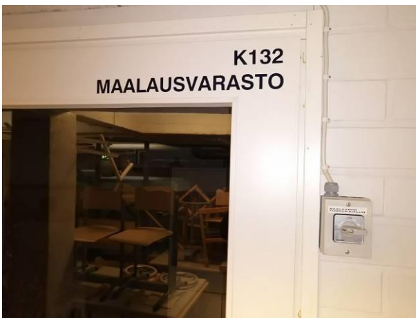
Kuva 31. Maalausvaraston poisto toimii käsikytkimellä erillisellä poistopuhaltimella.
