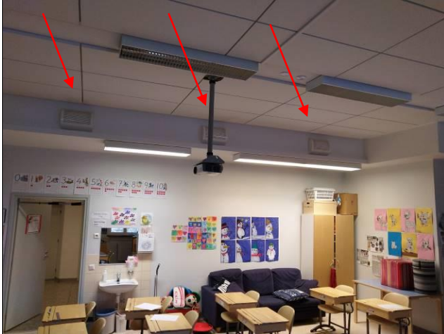
Kuva 6. OKE-200 tuloilmapäätelaitteet luokkatilassa
