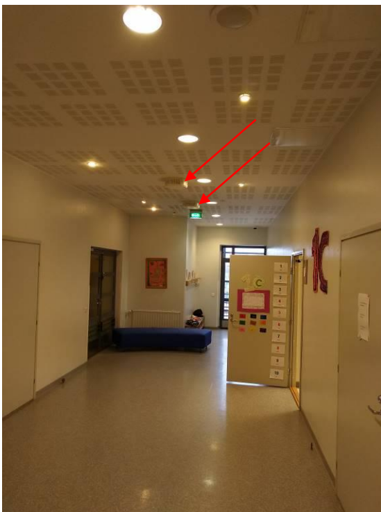
Kuva 12. Käytävät ovat ilmanvaihtoratkaisultaan puutteelliset
