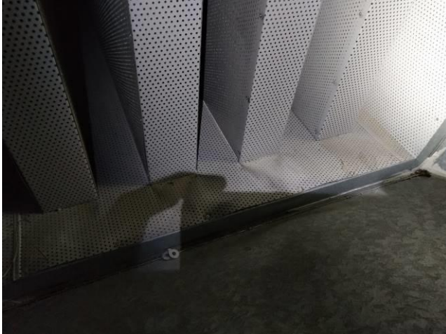
Kuva 74. Äänenvaimenninlamelleita tulopuolen kammiossa
