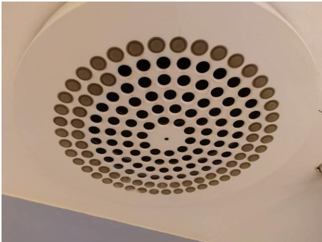
Kuva 8. SET-tyypin poistoilmasäleikkö
