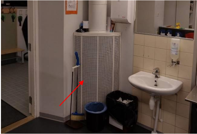
Kuva 62. Tuloilman jako on toteutettu yhdellä tulopäätelaitteella
