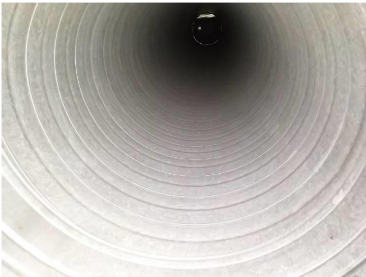
Kuva 18. Tuloilmarunkokanavassa ei havaittavissa pölyä pyyhkäisymenetelmää käyttäen.
