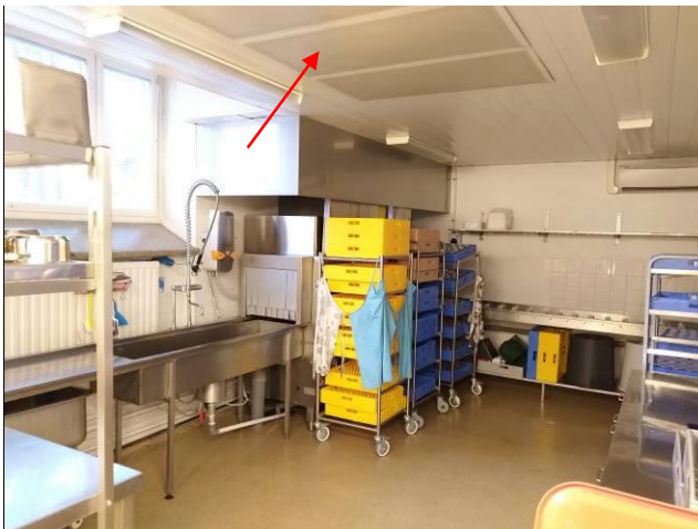
Kuva 71. Keittiön tuloilmapäätelaitteita katossa (merkitty nuolella) ja tiskaushuuva
