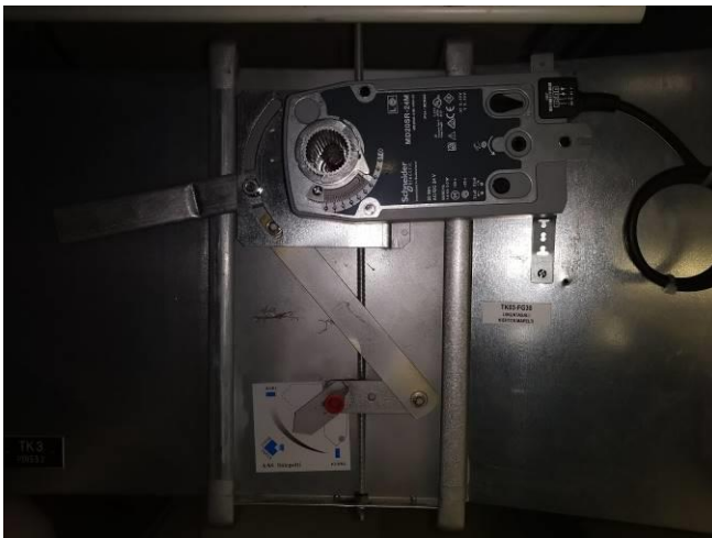
Kuva 44. Kiertoilmapelti ja asento tarkistushetkellä
