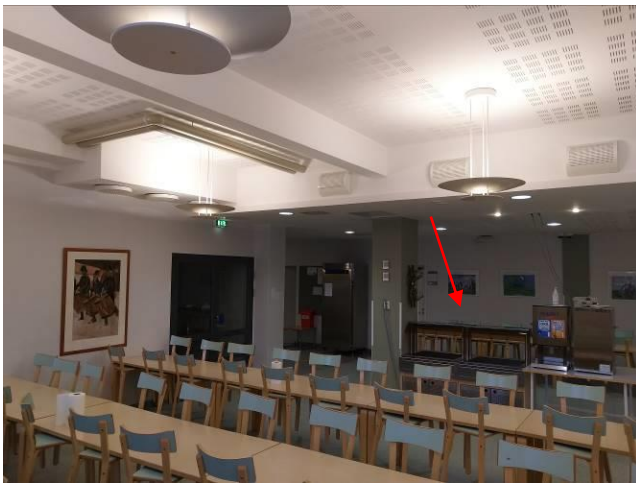
Kuva 14. Ruokalassa osa tilasta jää katvealueeseen tuloilman osalta
