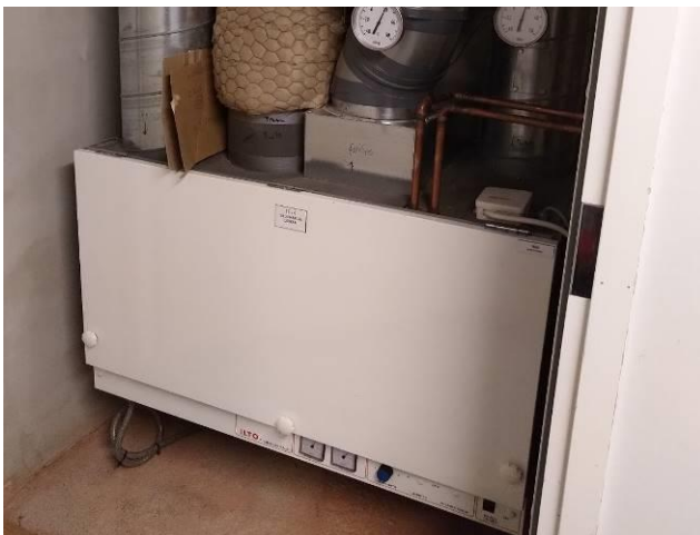
Kuva 58. TK4 ilmanvaihtokone
