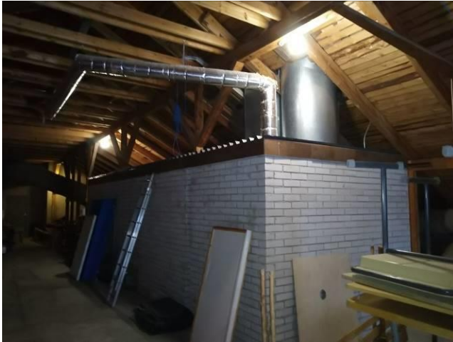
Kuva 70. TK05 on sijoitettu erilliseen muurattuun tilaan ullakolle
