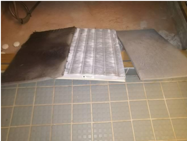
Kuva 64. Suodattimet olivat tarkistushetkellä erittäin likaiset
