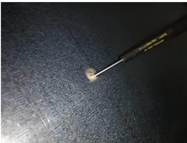
Kuva 52. Äänenvaimennuslamellien sisällä mineraalivillaa
