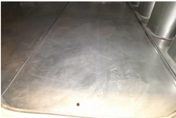
Kuva 34. Koneen tuloilmakammiossa reikäpelti ja alla mineraalivillaeriste
