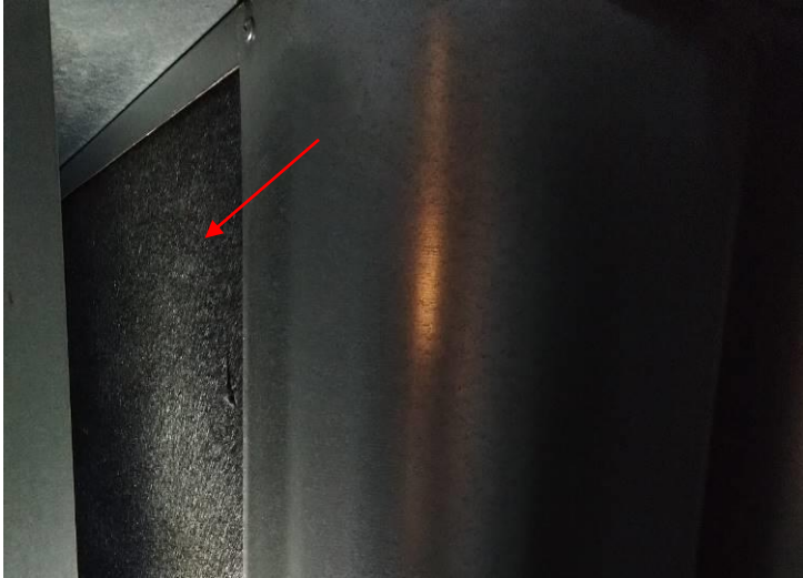
Kuva 9. Äänenvaimenninlamelleissa harsopinnoite
