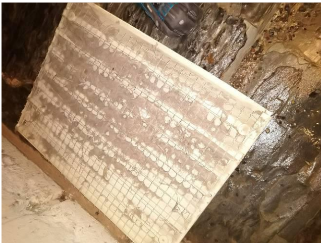
Kuva 65. Myös raitisilmasäleikkö oli likaantunut huomattavan paljon
