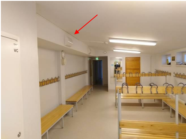
Kuva 46. Pukuhuoneiden tulot toteutettu OKE-200 tuloilmaventtiileillä
