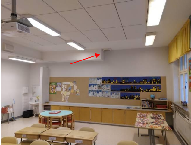
Kuva 29. OT230 poistoilmasäleikkö
