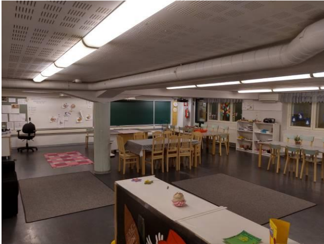
Kuva 60. Kerhotilaa, kanavistot ovat osittain näkyvissä.
