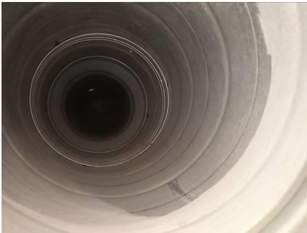
Kuva 33. Poistokanavistossa havaittavissa pölykertymää, pyyhkäisymenetelmää käyttäen
