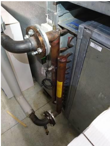
Kuva 69. TK5 LTO jälkilämmityspatteri
