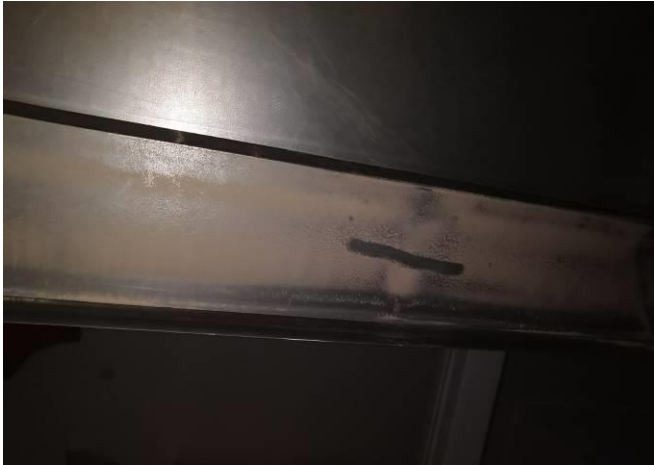
Kuva 35. Vuotoa havaittavissa teknisen työn poistosuodatuksessa
