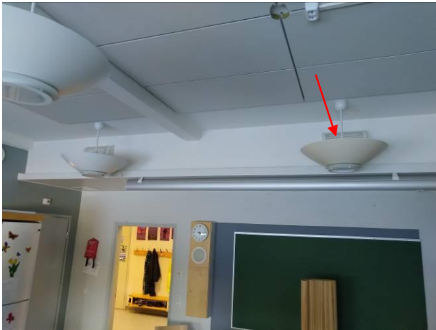
Kuva 13. OKE-200 tuloilmapäätelaitteet joissa osa ilmasta törmää edessä oleviin valaisimiin
