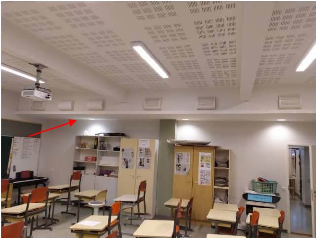
Kuva 36. Luokan K105 (entistä ruokalaitilaa) kaksi tuloilmaventtiiliä oli tukittu paperilla ja teipillä
