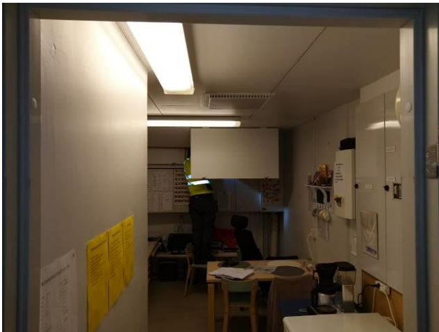
Kuva 73. Toimistotila ja tulopäätelaite. Kattoluukku vanhalle käytöstä poistetulle iv-koneelle
