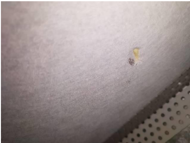
Kuva 80. Keittiön tulopäätelaitteissa harsopinnoitettu mineraalivillaeriste
