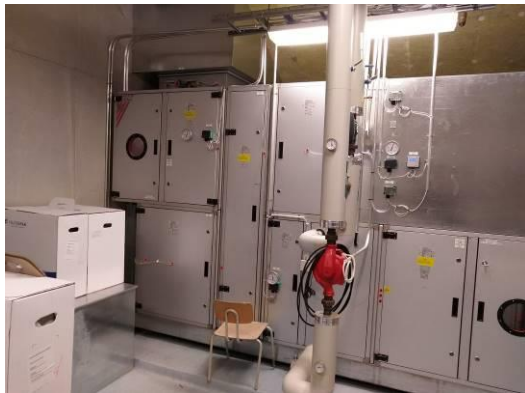
Kuva 4. TK01 ilmanvaihtokone
