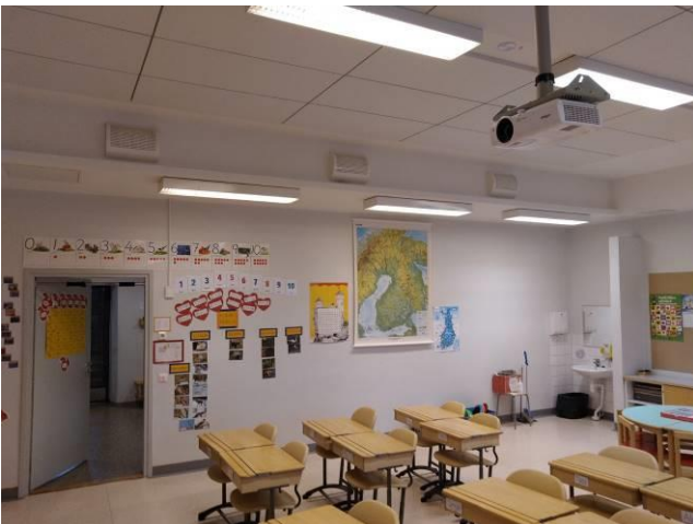
Kuva 28. OKE tuloilmapäätelaitteet OT230 luokkatilassa
