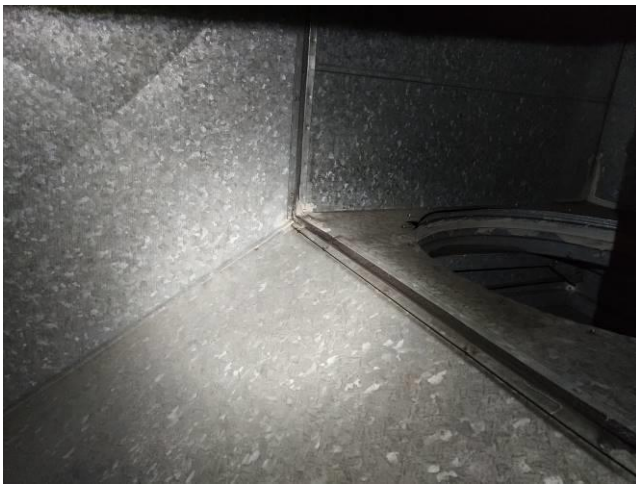
Kuva 75. Tulopuolen lamelleiden jälkeinen kammio ilman eristeitä.
