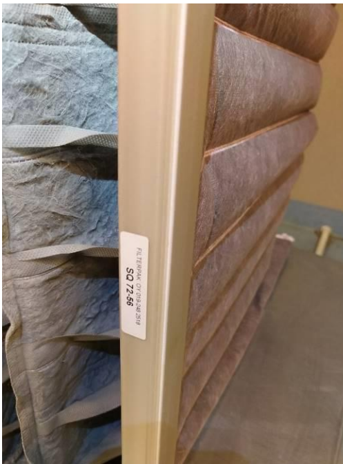
Kuva 16. Väärä poistosuodatin (F7 tulosuodatin)
