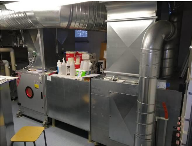
Kuva 54. Poistopuolella ei ole omaa suodatinta. Osa poistoilmasta kierrätetään takaisin tuloilmaan ja suodatetaan tuloilmasuodattimen läpi.
