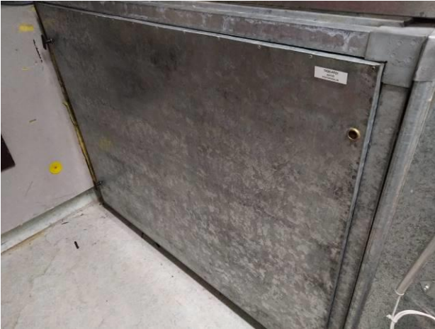
Kuva 76. Poistopuhaltimen luukun kiinnitys heikko ja osittain rikki
