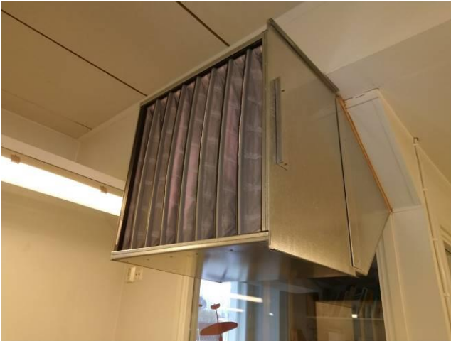
Kuva 26. Poistosuodatus kellarin teknisen työn tiloissa (F7)
