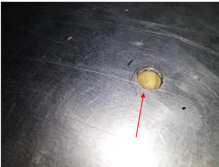
Kuva 10. Tarkistusreiästä havaittavissa mineraalivillaa lamellien sisällä.
