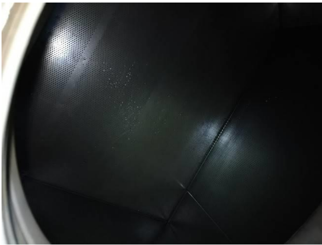
Kuva 51. Tuloilmakammiossa reikäpelti ja alla harsopäällysteinen mineraalivillaeriste
