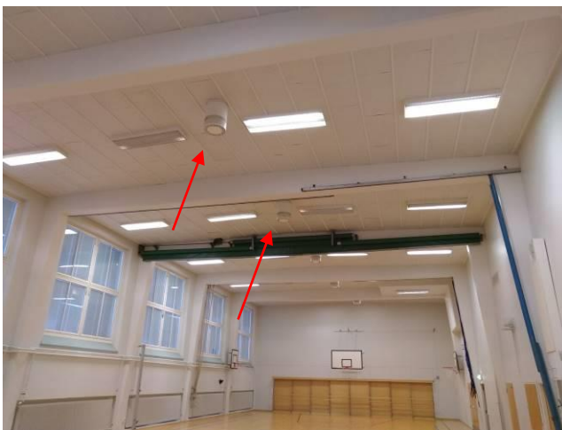
Kuva 48. Liikuntasalin tulopäätelaitteita
