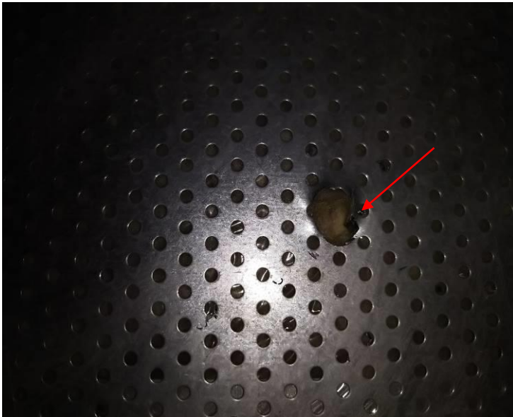
Kuva 11. Tuloilmakammiossa reikäpelti ja sen alla mineraalivillaeriste.
