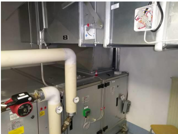
Kuva 42. TK3 Tuloilmakone, kiertoilmapelti ja kanavaliitos raitisilmakammioon
