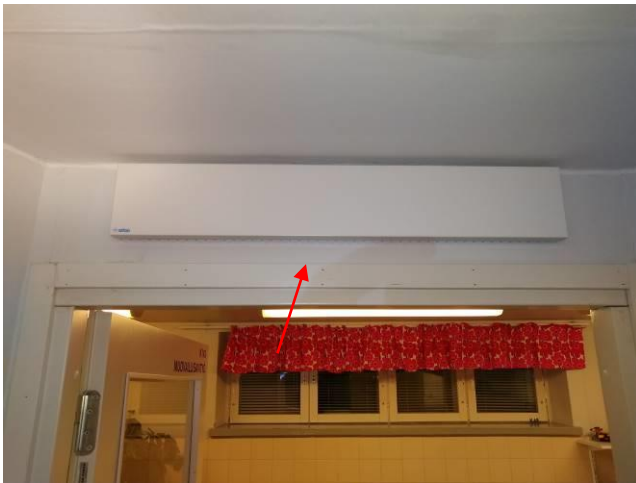
Kuva 61. Leikki-tilan siirtoilmasäleikkö
