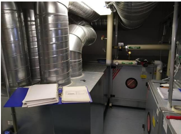
Kuva 43. TK3 Tuloilmakone ja lähtevät runkokanavat
