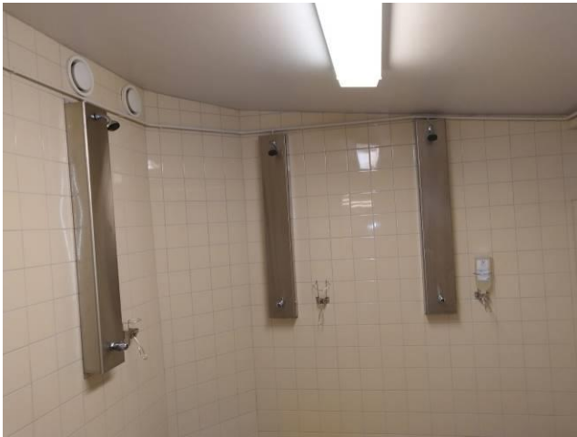
Kuva 49. Pesutiloissa pyöreät KSO poistoilmaventtiilit
