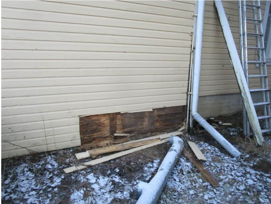
Kuva 31. Ulkoseinän avaus pitkältä sivulta.
