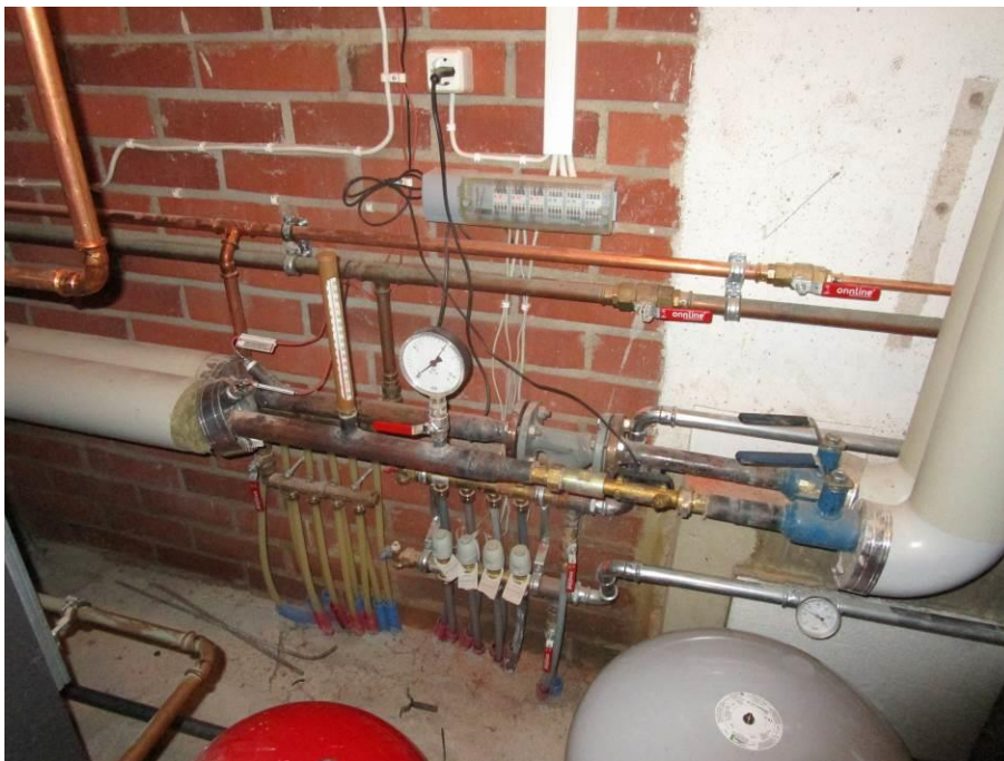
Kuva 49. Laajennusosan jakotukit
