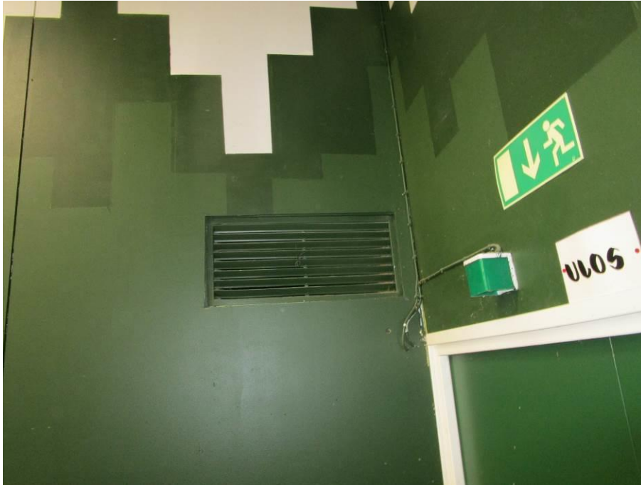
Kuva 62. Tuloilmakoneen kiertoilmasäleikkö
