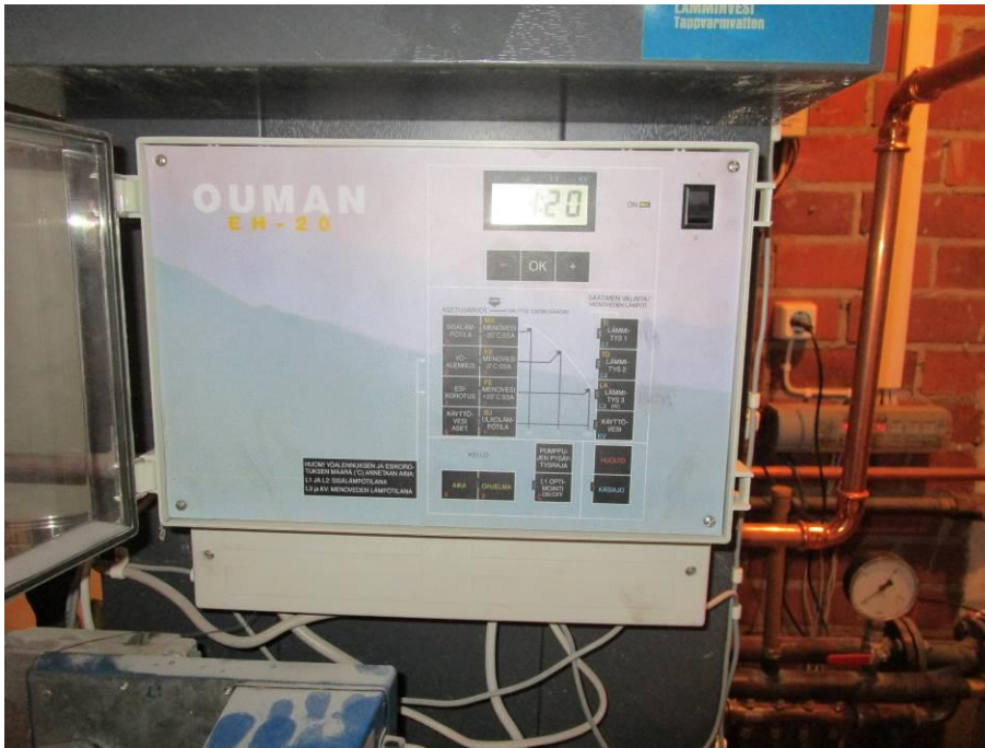
Kuva 48. Yksikkösäädin
