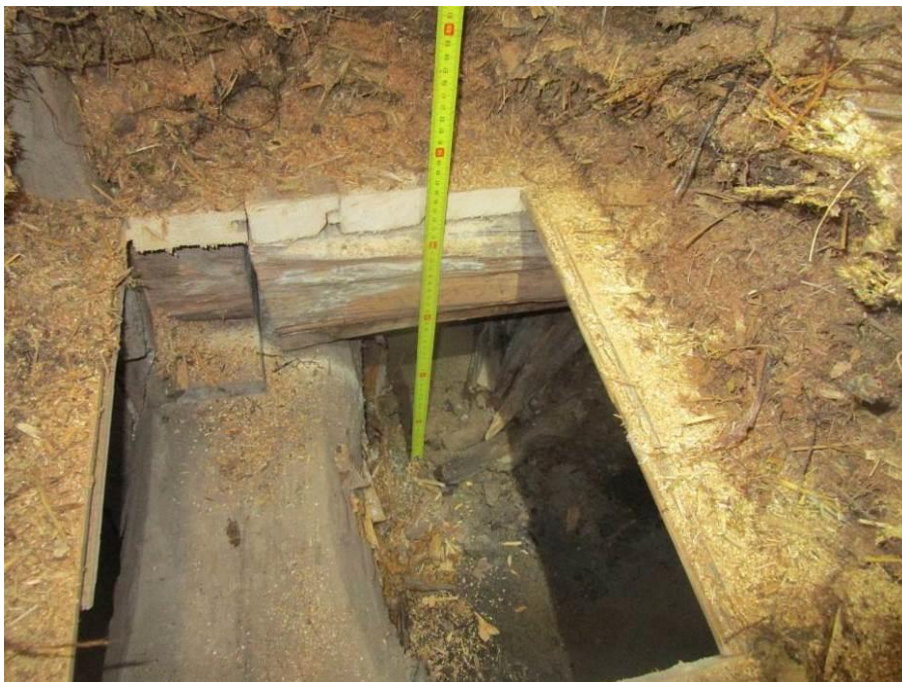
Kuva 4. Täytepohjan aluslaudoitus poistettiin tuuletustilaan saakka.
