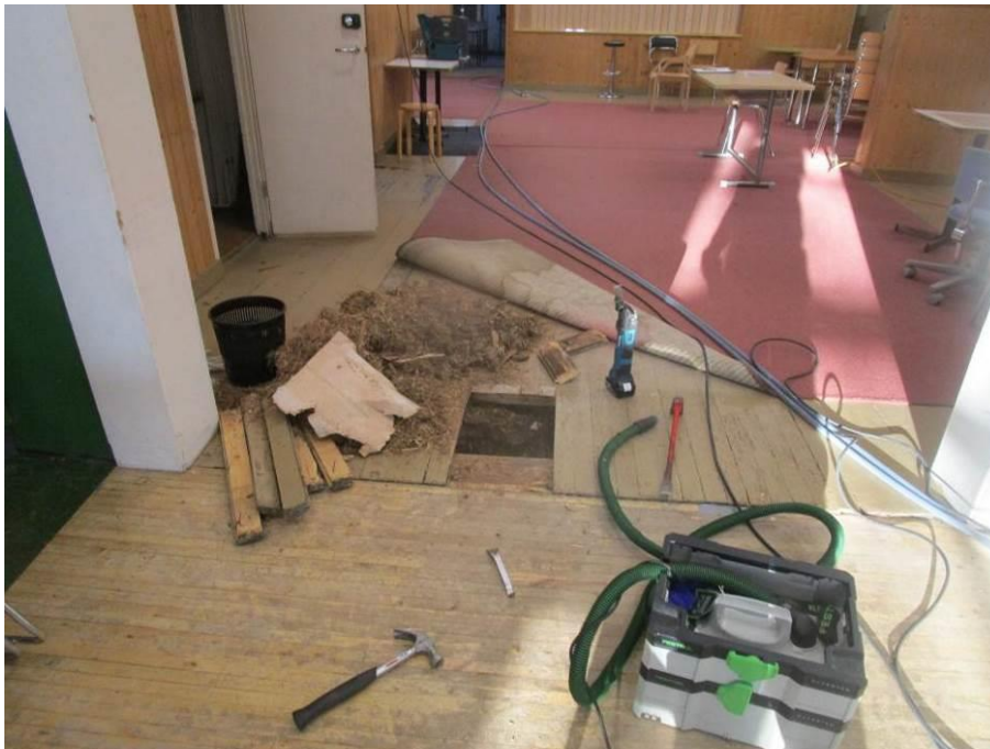
Kuva 7. Rakenneavaus aulasta.
