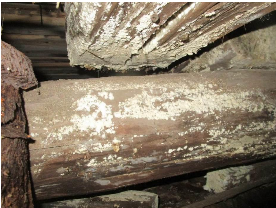
Kuva 9. Palkeissa voimakas mikrobikasvu.
