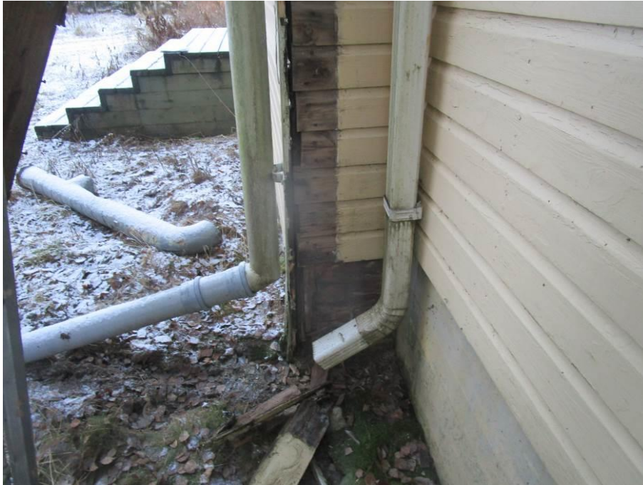
Kuva 29. Nurkkalaudoitusta ja panelointia poistettiin.
