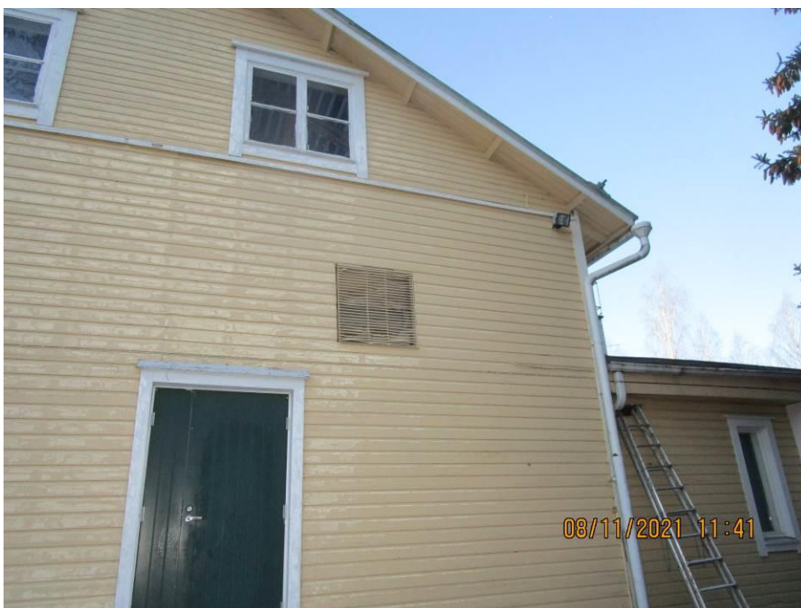
Kuva 61. Tuloilmakoneen raitisilmasäleikkö
