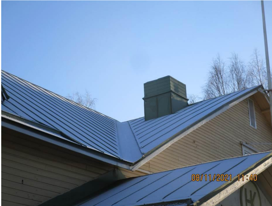
Kuva 64. Isompi huippuimuri
