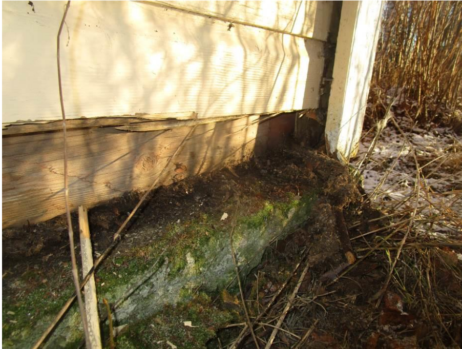
Kuva 19. Sokkeli tulee julkisivun ulkopuolelle.
