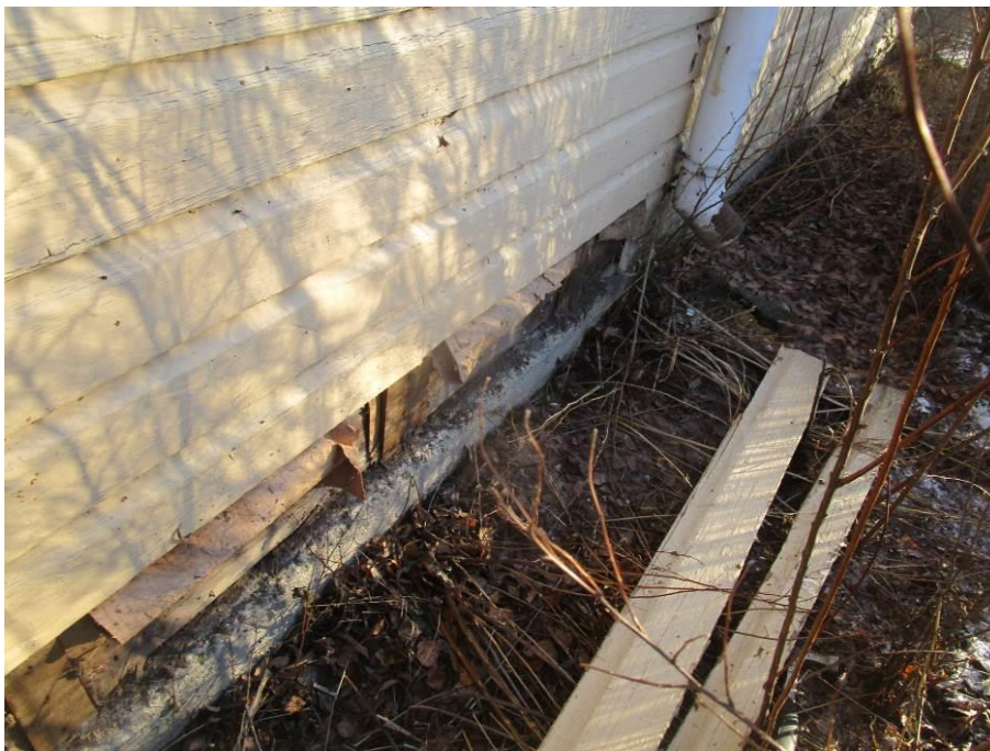
Kuva 16. Paneeli tausta tarkastettiin paneelit poistamalla.
