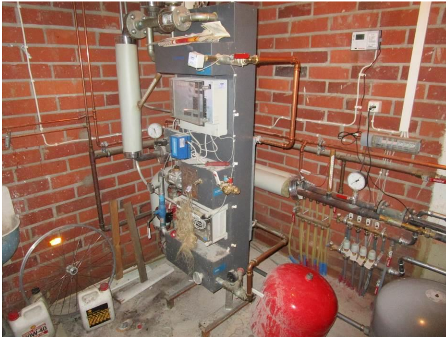
Kuva 44. Lämmönsiirtimet
