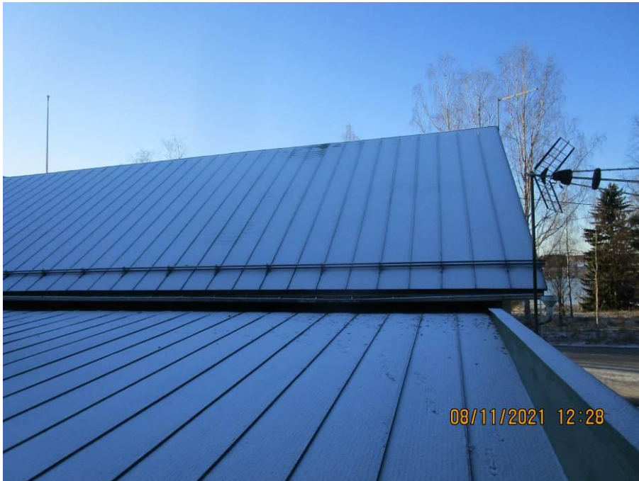
Kuva 40. Alkuperäisen osan vesikatto.
