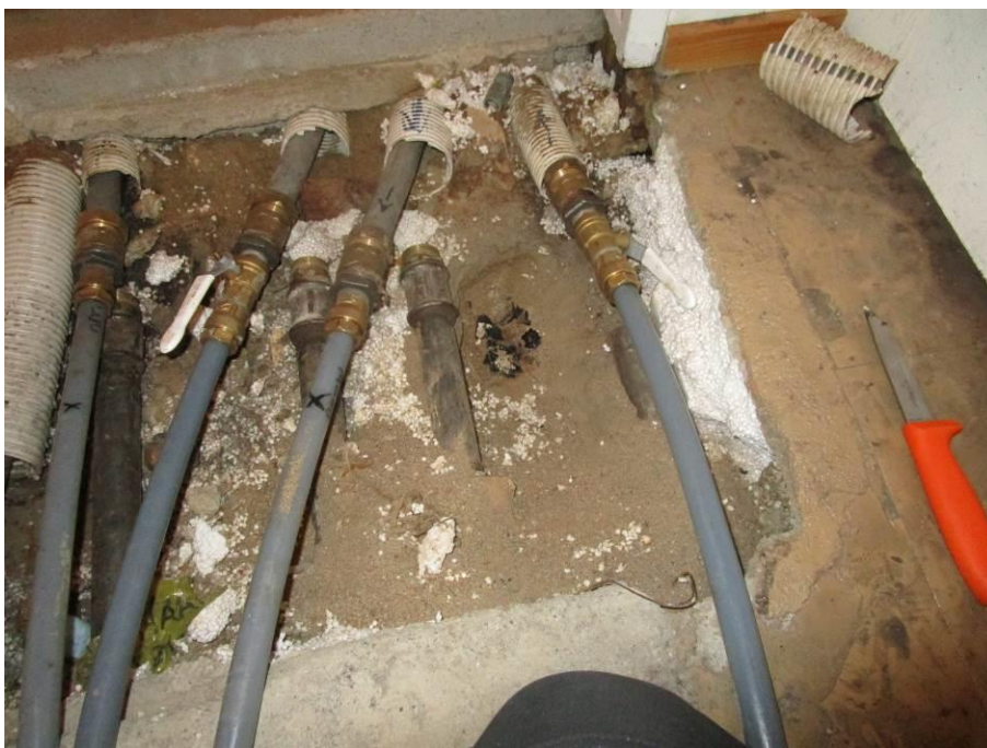
Kuva 13. LVI-putkistojen tarkastuskaivo
